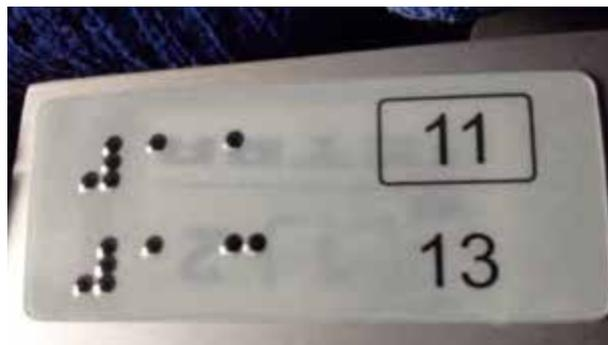
Bild 30: Taktile ertastbare (Punktschrift) und visuell kontrastierende Sitzplatznummerierung – Detailansicht
