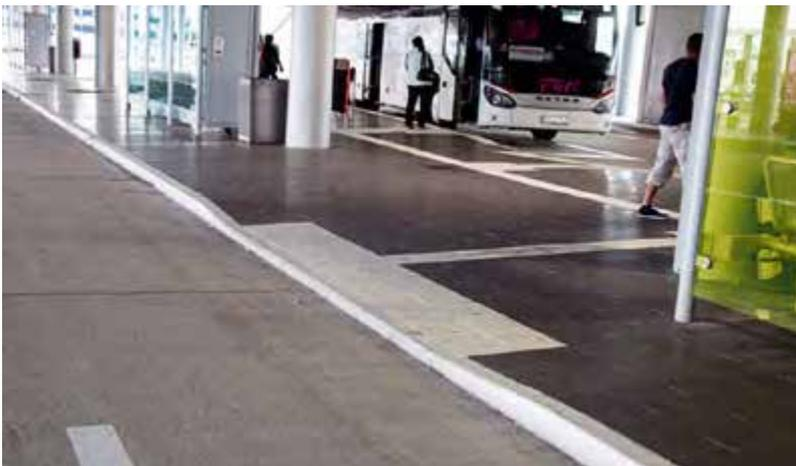
Bild 50: Überquerungsstelle mit einheitlicher Bordhöhe – Stuttgart
