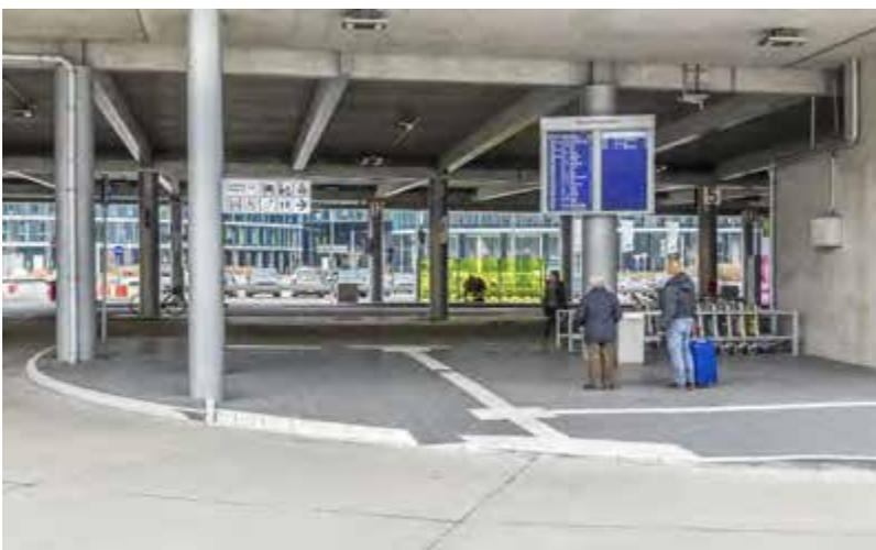
Bild 52: Überquerungsstelle mit differenzierter Bordhöhe – Stuttgart
