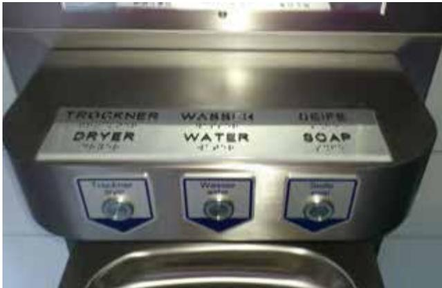
Bild 63: Taktile ertastbare und visuell kontrastierende Beschriftung von Bedienelementen
