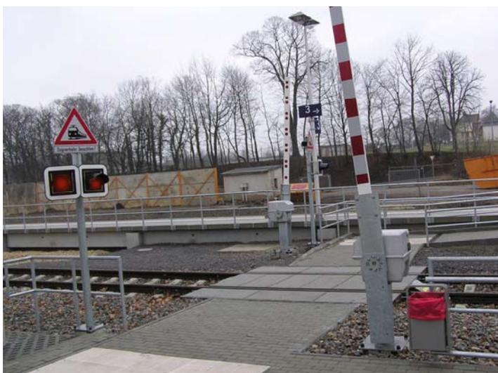
Abbildung 26: Beispiel für visuelle Warnung in mittlerer Sichthöhe an einem Reisendenübergang
