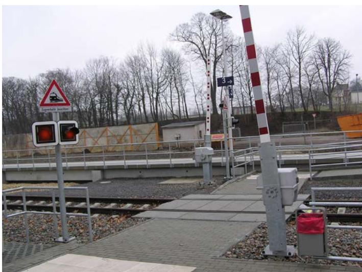
Abbildung 22: Beispiel für visuelle Warnung in mittlerer Sichthöhe an einem Reisendenübergang
