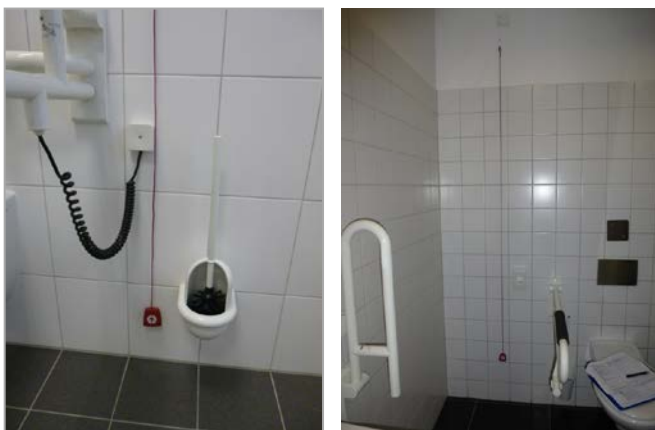
Abbildung 7 Beispiele für Anordnung des Auslösemechanismus der Notrufanlage
