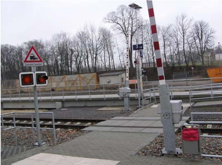
Abbildung 17: Beispiel für eine visuelle Warnung in Sichthöhe an einem Reisendenübergang
