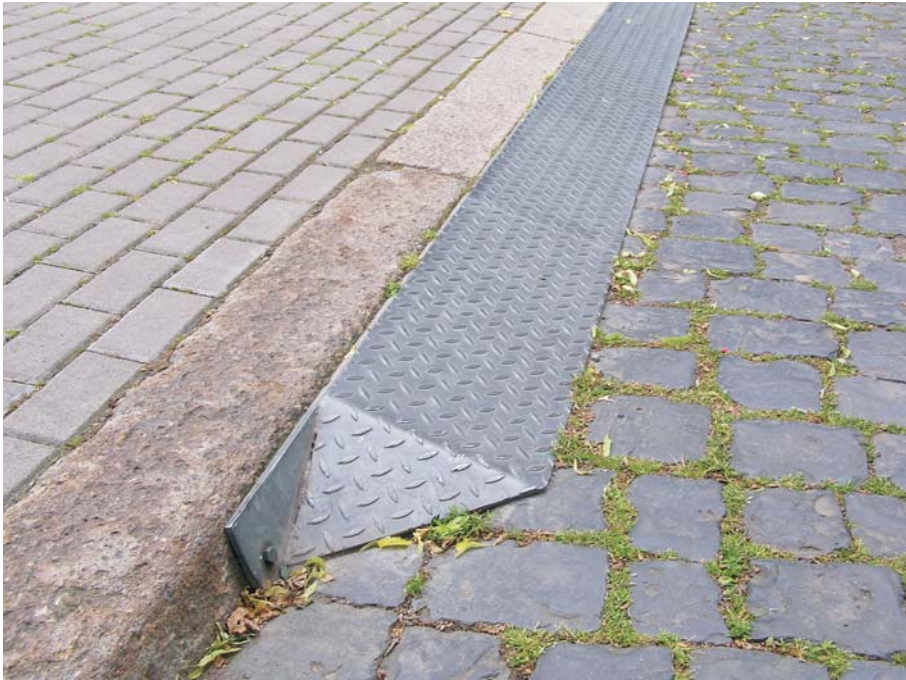
Bild 10: Minirampe aus Metall zur Überwindung des Bordsteins
