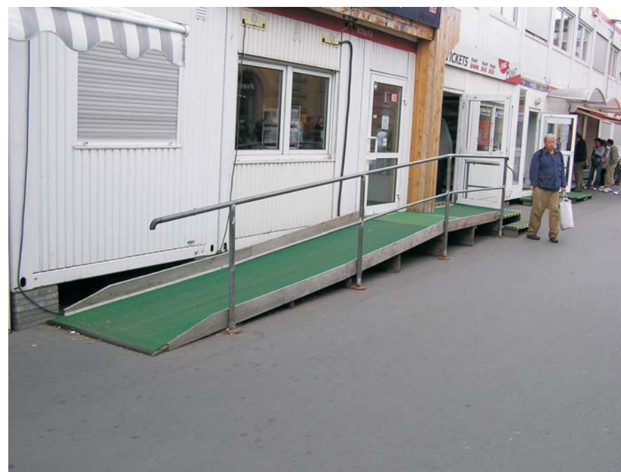
Bild 8: Temporäre Rampe mit Teppichauflage
