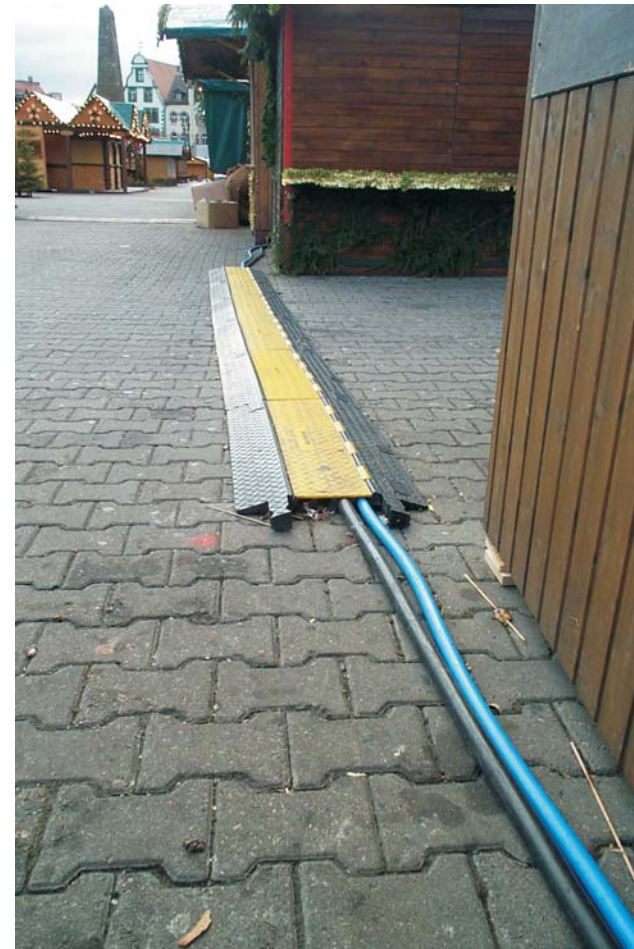
Bild 3: Kabelbrücke in Kontrastfarben
