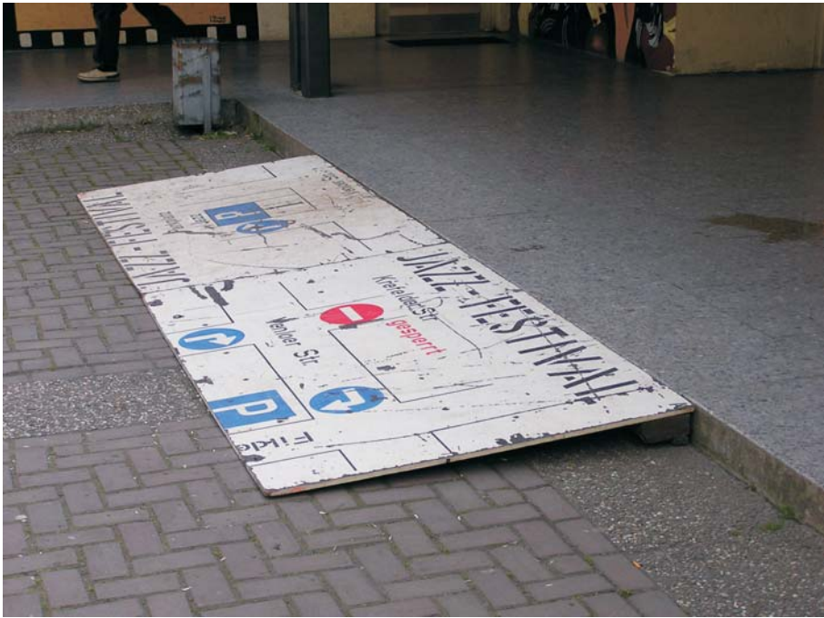
Bild 9: Temporäre Rampe aus Holz (Recyclingmaterial); ideal wäre noch eine seitliche Markierung mit gelben Kontraststreifen
