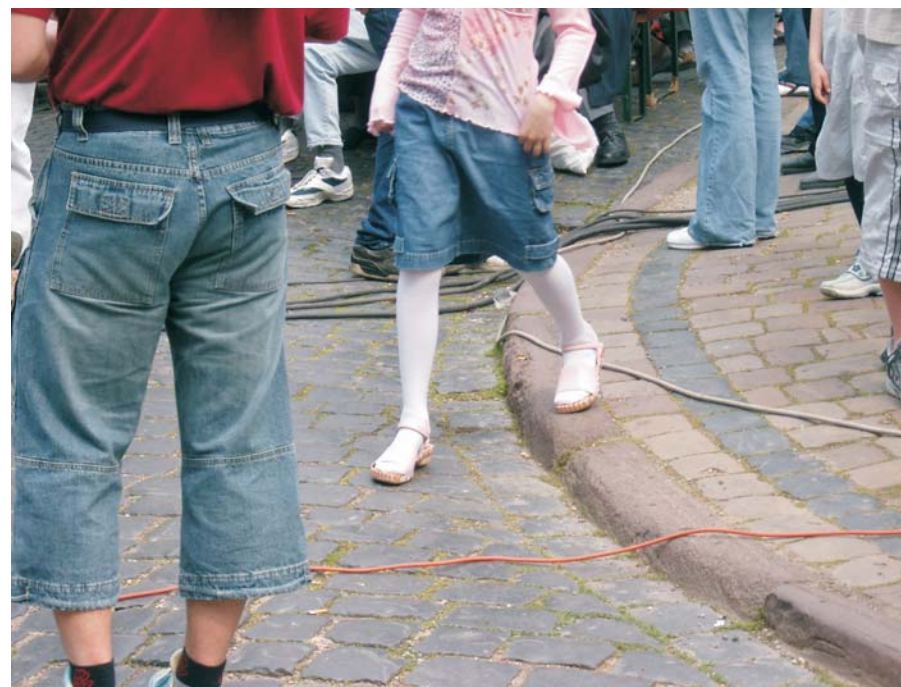
Bild 2: Ungünstige Kabelverlegung (Foto: Stephan Grönefeld/Darius Höhne)
