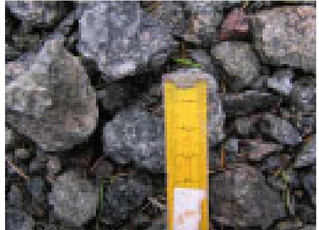
*Abb. 26: Zu grober Schotter auf einem Wanderweg. Wird Schotter zur Festigung der Deckschicht verwendet, so sollte dieser einen Durchmesser von 1 cm nicht überschreiten. Scharfe Steinkanten können zudem das Pannenrisiko für Rollstuhl- und Radfahrer erhöhen.*
